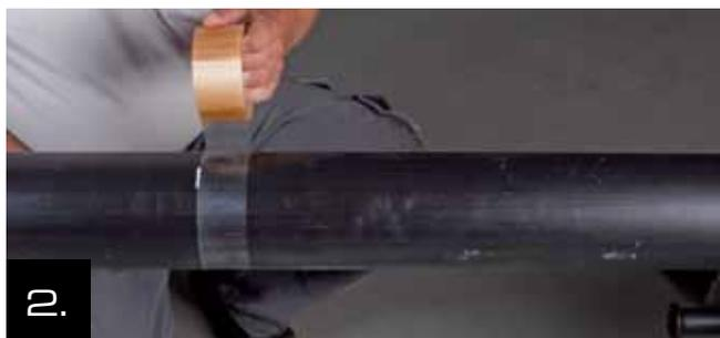
2. Marque la línea de corte con una cinta adhesiva alrededor de la tubería.
