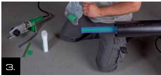
3. Saque el manguito fusiotherm® del embalaje. Las conexiones deben ser limpiadas.
