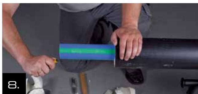
8. Limpie el tubo pelado y escarfe el final de la tubería por el interior y el exterior.
