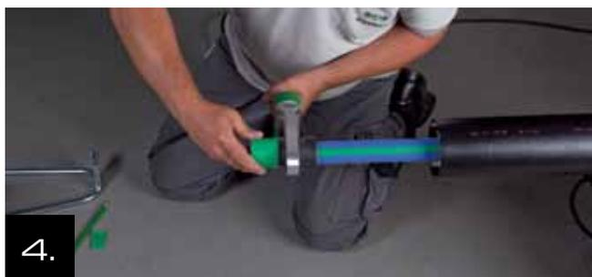
4. Introducir el manguito, en el macho de la matriz de soldadura y al mismo tiempo empuje la tubería hasta la línea de profundidad de soldadura marcada en la hembra de la matriz.
