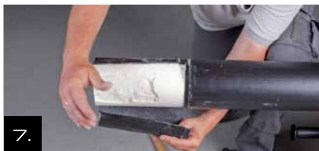
7. Quite el extremo de cubierta de la tubería y elimine la capa de aislamiento de poliuretano alrededor de la tubería.
