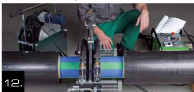
12. Después de que se ha alcanzado la cuenta previa, la presión es reducida en el sistema hidráulico. Entonces comienza la fase el calentamiento. En ese momento, se enfrentan los dos extremos de la tubería, calentándose hasta la temperatura de soldadura requerida.
