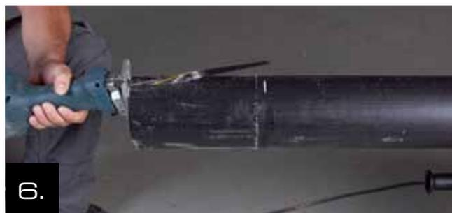
6. Corte la cubierta hasta la capa de aislamiento de poliuretano con una sierra de mano el plástico.
