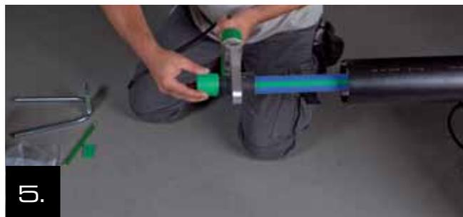
5. Después del tiempo de calentamiento indicado, extraer el accesorio y la tubería de la matriz.
