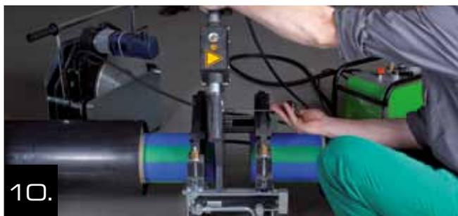
10. Inserte el dispositivo de soldadura entre los extremos del tubo. Compruebe, si el placa de soldadura está limpia, medir la temperatura de soldadura.
