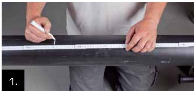
1. Mida la longitud del tubo y marque en la cubierta de la tubería.
