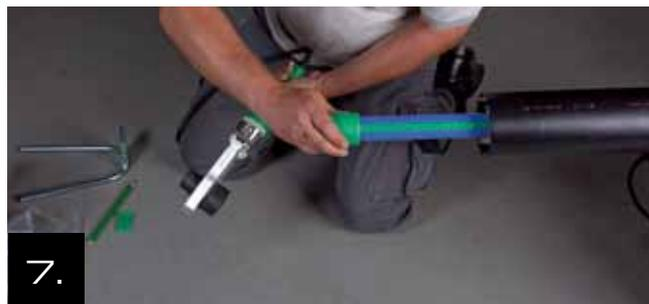
7. Dentro del tiempo de soldadura, presione el manguito en el extremo de la tubería hasta el la línea de profundidad de soldadura marcada.
