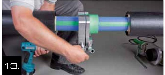
13. Después del tiempo de enfriamiento, retire la mordaza de la tubería, desenroscando el tornillo de fijación.
