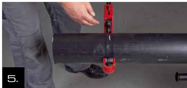
5. Corte la cubierta de la cañería con el cortador de tubo, hasta la capa de aislamiento de poliuretano que recubre la tubería.
