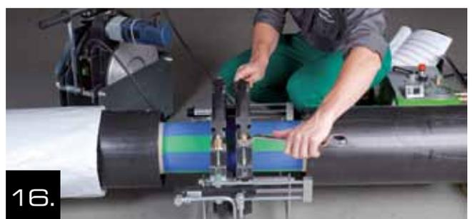
16. Tras el final del período de enfriamiento se libera la presión en el sistema hidráulico. Posteriormente, se desconecta la abrazadera y el dispositivo de sujeción se retira.
