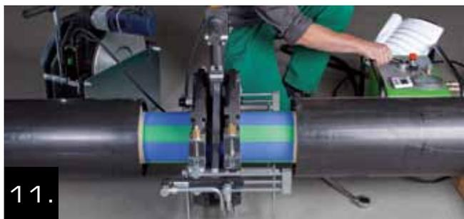
11. Conducir lentamente contra la chapa de soldadura el carro de la máquina, poniendo en funcionamiento el sistema hidráulico. A continuación, de ajuste la presión de los tubos con la plancha de soldadura hasta el valor predeterminado.
