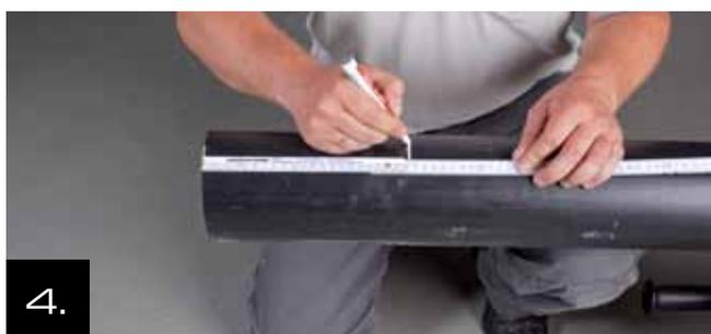
4. Marque una longitud de pelado de 22,5 cm desde el extremo del tubo en la cubierta de la tubería.
