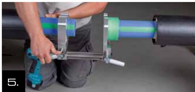
5. Tire del extremo del tubo hasta el final de la marca de la plantilla de soldadura y apretar las mordazas de sujeción con el tornillo de fijación.
