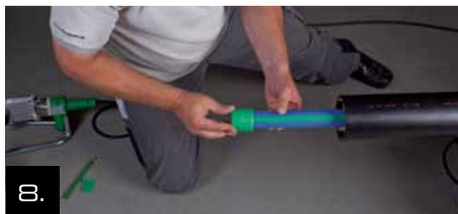
8. Alinear y fijar el maguito. Para continuar el proceso, hay que esperar el tiempo específico de enfriamiento.
