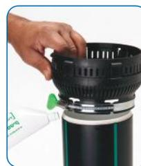
**6** Para facilitar el montaje se recomienda el uso del lubricante Huliot.
